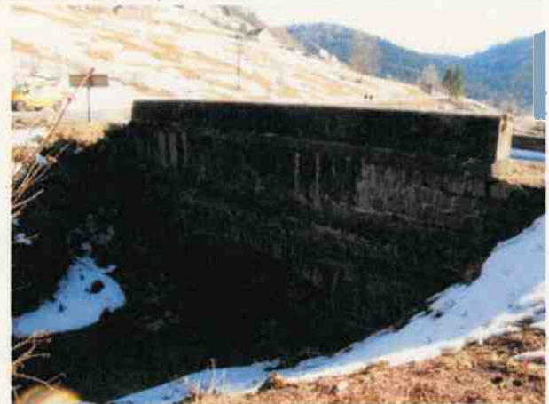
PHOTO 2 – Vue de l'amont de l'ouvrage
