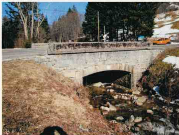
PHOTO 1 – Vue de l'aval de l'ouvrage
