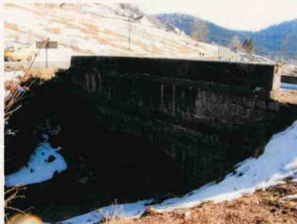
PHOTO 2 – Vue de l’amont de l’ouvrage
