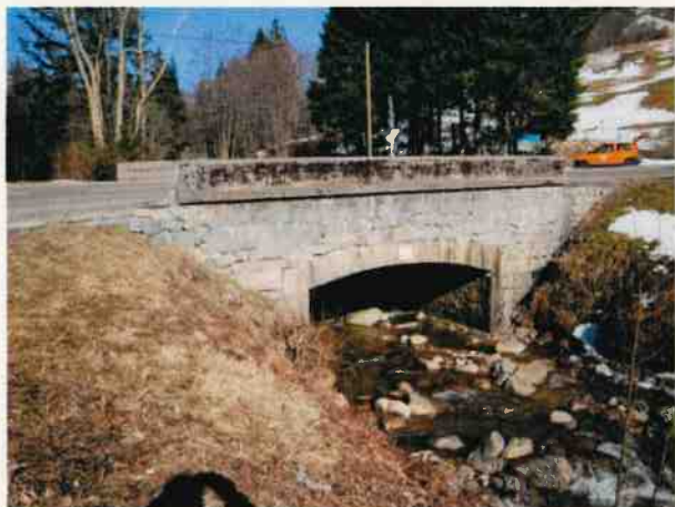
PHOTO 1 – Vue de l’aval de l’ouvrage
